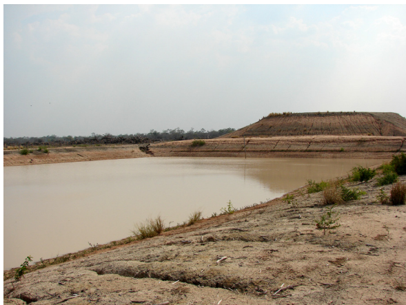
Figura 4. Tajamar y reservorio de agua, infraestructura utilizada para almacenamiento y distribución de agua en el Chaco Paraguayo.
