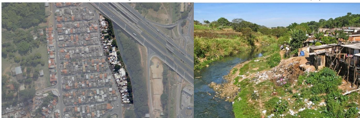
Figura 1. Direita: Imagem aérea destacando as habitações atendidas, lindeiras ao Ribeirão Anhumas, Campinas, SP. Esquerda: Fotografia ilustrativa caracterizando a vulnerabilidade da ocupação.
