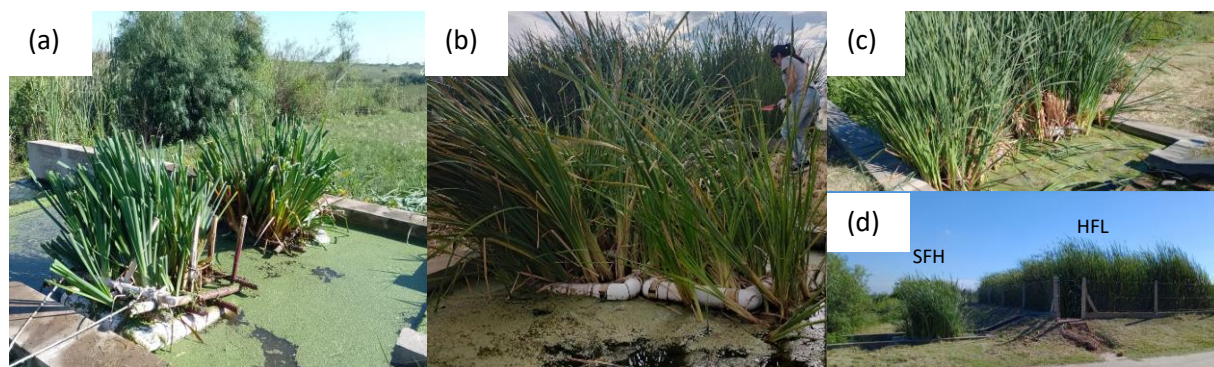
Figura 1. (a) SHF luego de dos meses de instalado (febrero 2023), (b) SHF diciembre 2023, (c) SFH diciembre 2024, (d) Vista del sistema HH.
